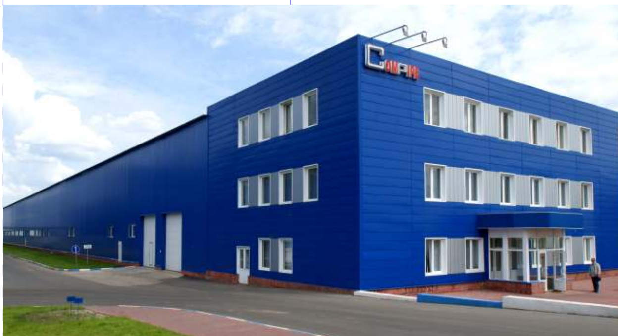
Каширский завод стали с покрытием, Московская обл., г. Кашира
